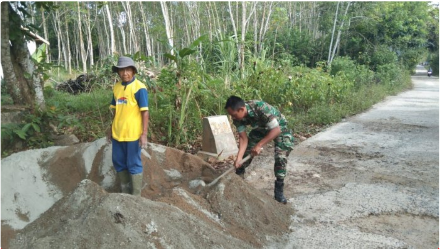
Babinsa Bantu Gotong Royong Pengecoran Jalan
